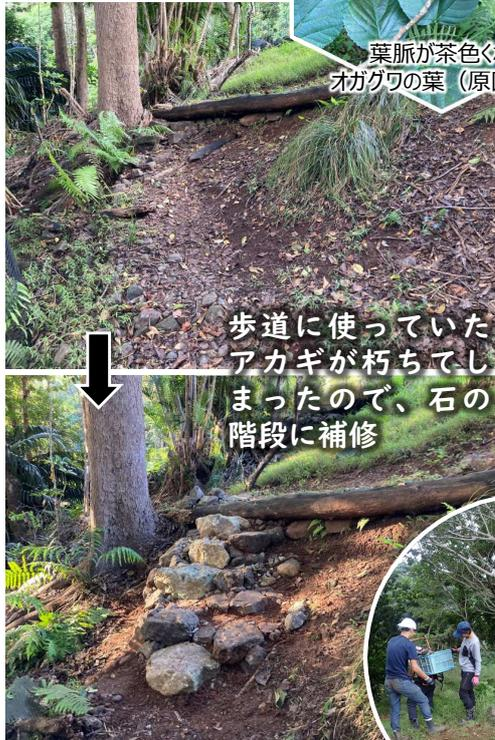
歩道に使っていたアカギが朽ちてしまったので、石の階段に補修
